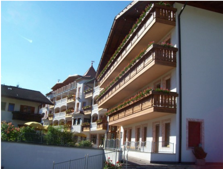
Im hinteren Gebäudetrakt ganz oben die Balkone "unserer" Suite
