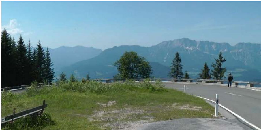
Roßfeld-Höhen-Ringstraße. Blick nach Westen
